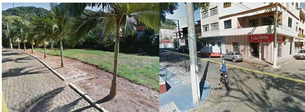
Figura 54 – Aspectos da microdrenagem implantada no município
