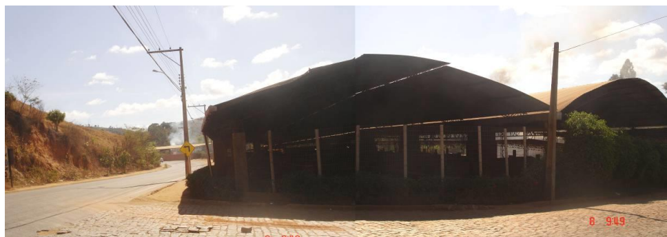
Figura 3-10 - Olaria na ES-080, na entrada para o bairro Vila Espanhola.
