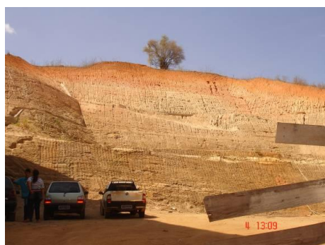
Figura 3-11 - Risco de escorregamento na margem da ES-080, bairro Cinco Casinhas.
