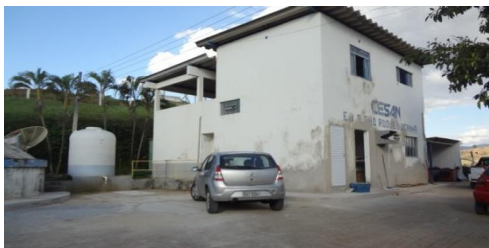
Figura 3-28 - Estação de Tratamento de Água.
